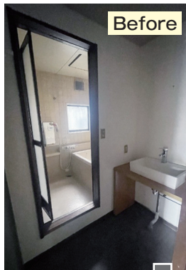
▲2階にあったもう1つの浴室
